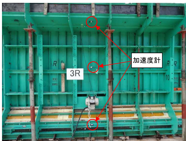
写真－1 加速度計の設置
